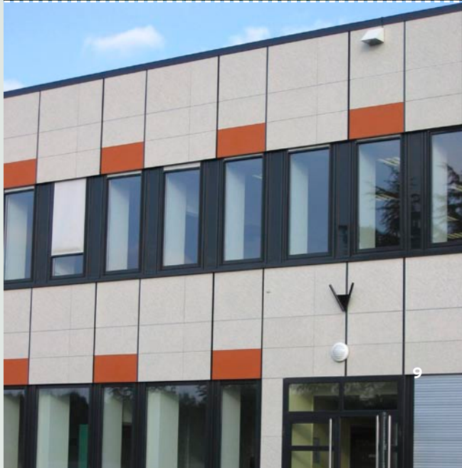
Здание школы Le Pont de Moine было построено в 1970-х из бетонных блоков. Для того, чтобы решить проблему плохой теплоизоляции, фасад был заменен навесным фасадом CW 86.
